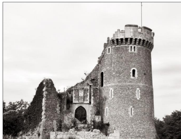
Le château Robert le Diable est en cours de restauration par une association de réinsertion, dont le siège se trouve à Elbeuf, au moyen de plusieurs équipes d'ouvriers qui se relaient.
